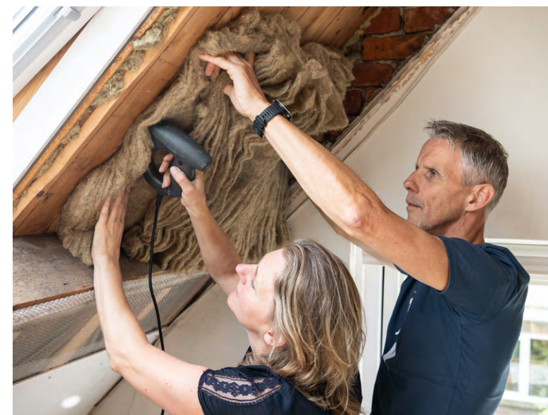
Het aanbrengen van woningisolatie.
